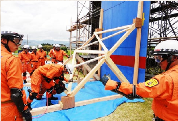
エアネイラーで迅速・的確にショアリングを作成
