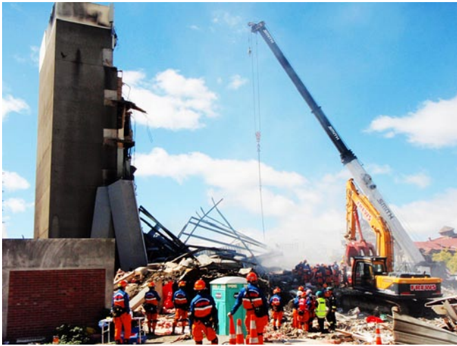
重機を使用した救助の様子
